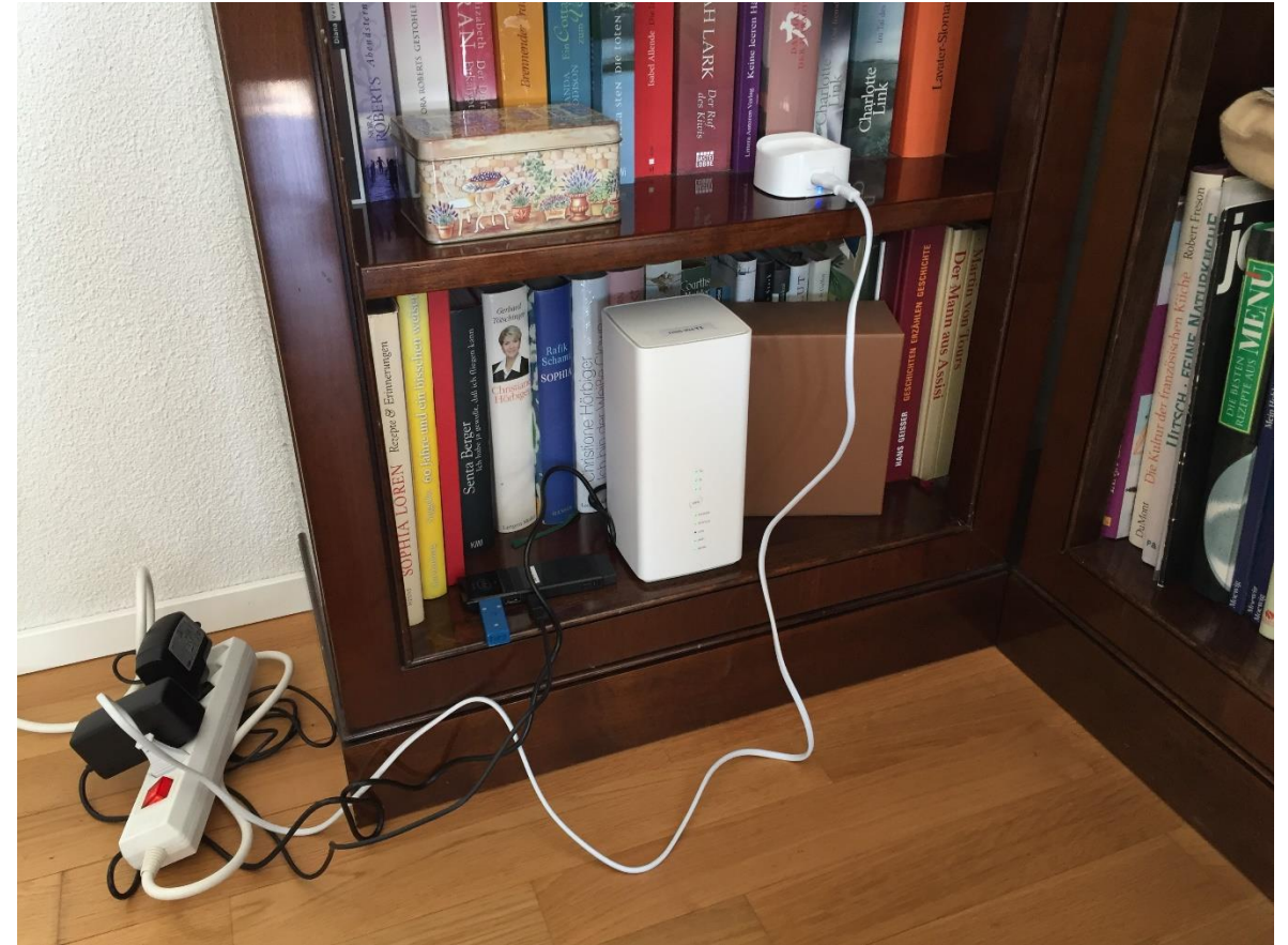
Installation der Liveübertragung/Positionierung der Ladestation
